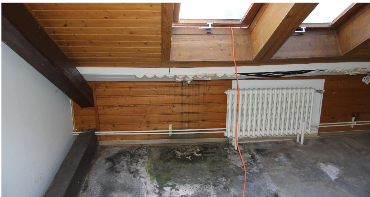
Obr.: 1 Zatekanie v podkroví
