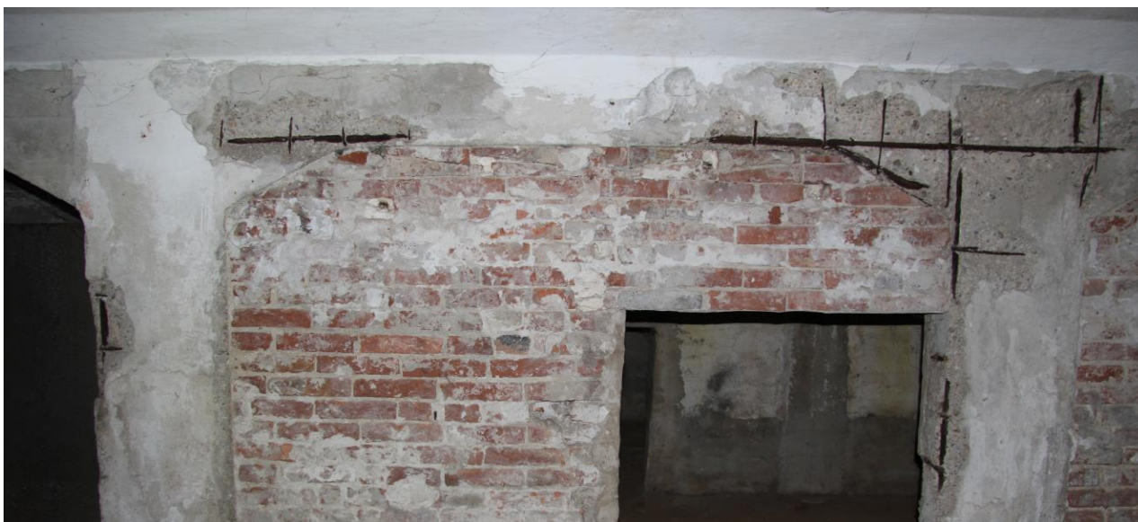
Obr.: 10 Poškodená krycia vrstva – je možné reprofilovať
