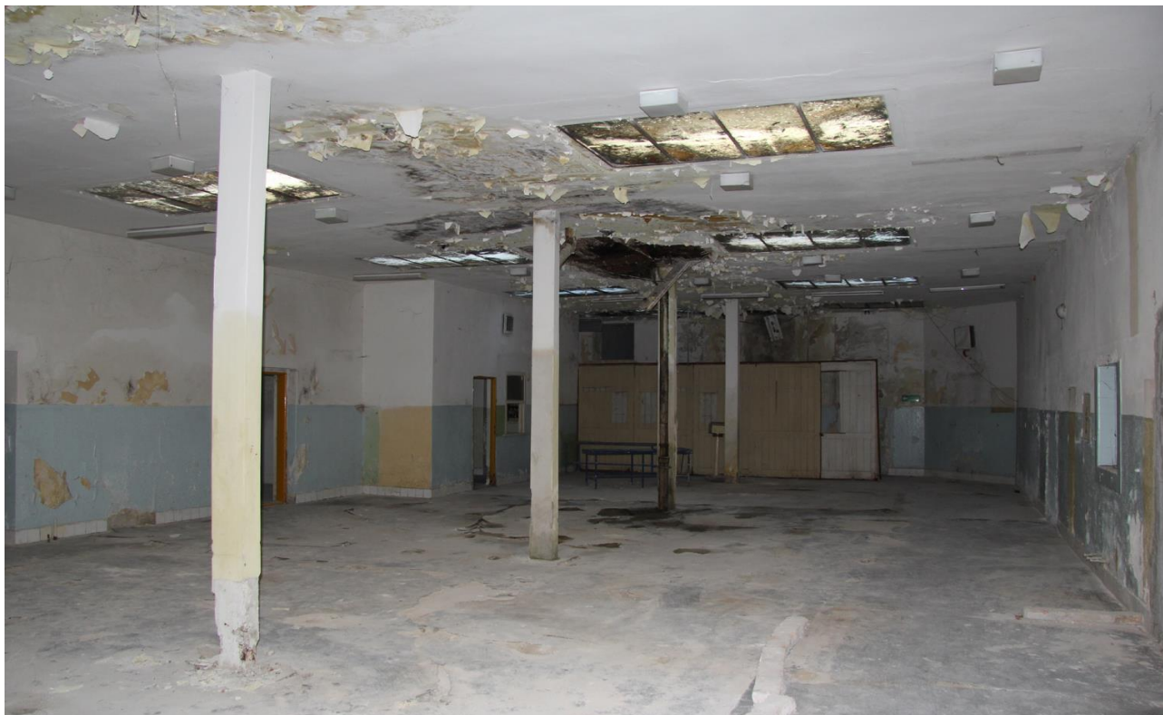
Obr.: 15 Veľká miestnosť v časti K – strop v havarijnom stave
