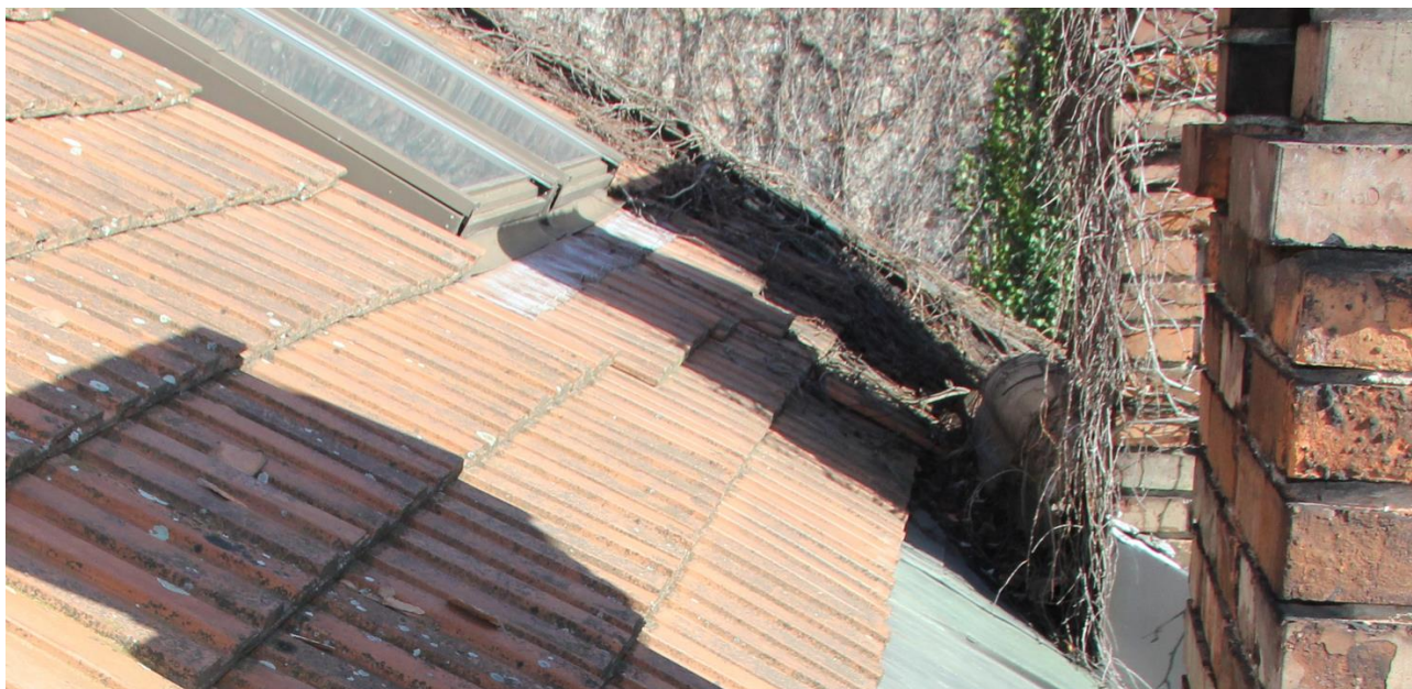
Obr.: 2 Kritický detail – medzi strešným oknom a komínom
