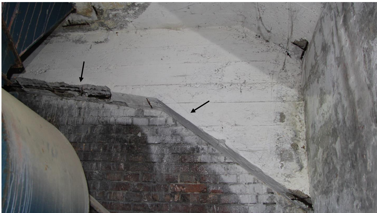
Obr.: 5 Pohľad na rebro stropu – poškodená spodná výstuž, odprasknutá krycia vrstva
