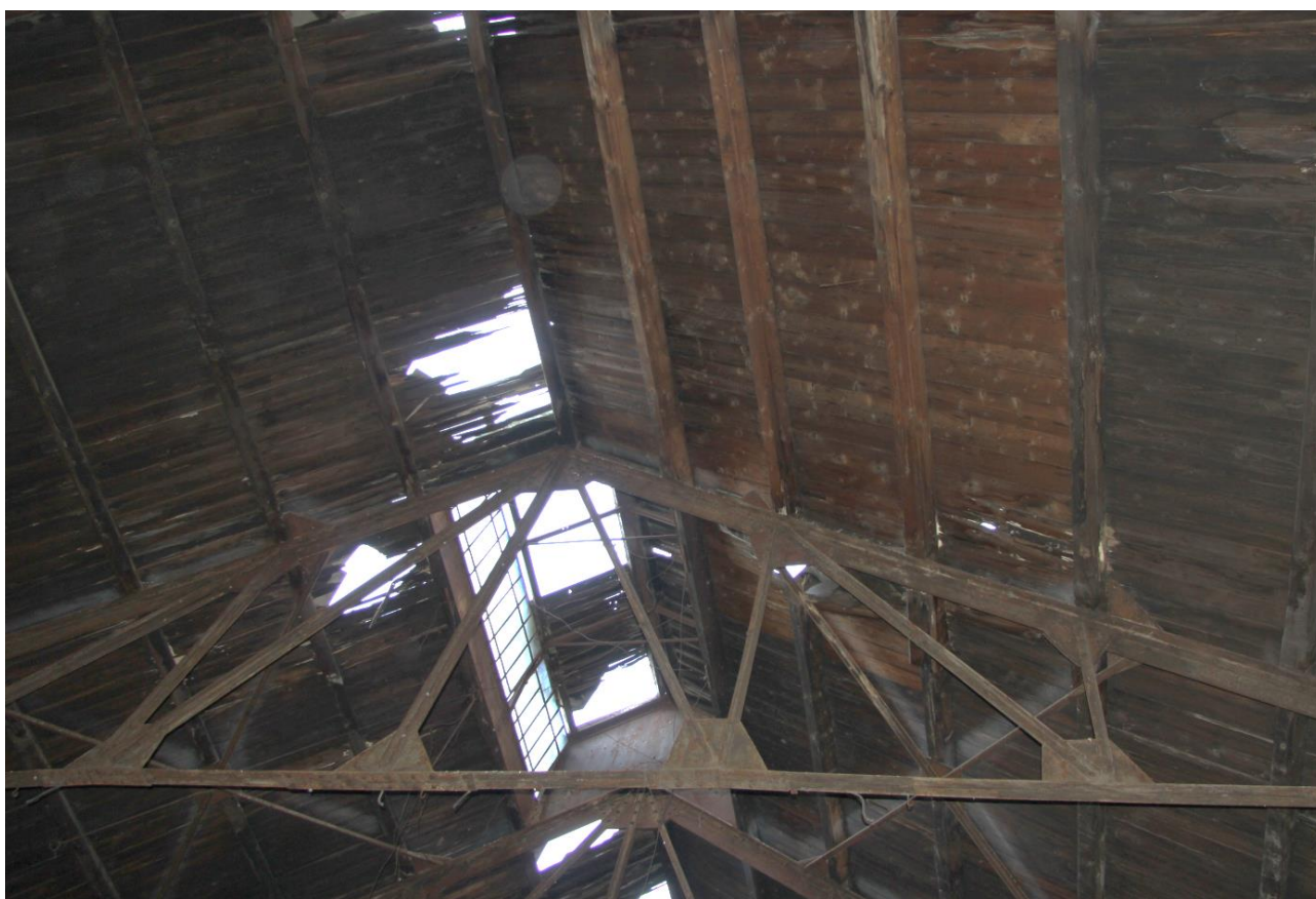
Obr.: 13 Poškodená strecha
