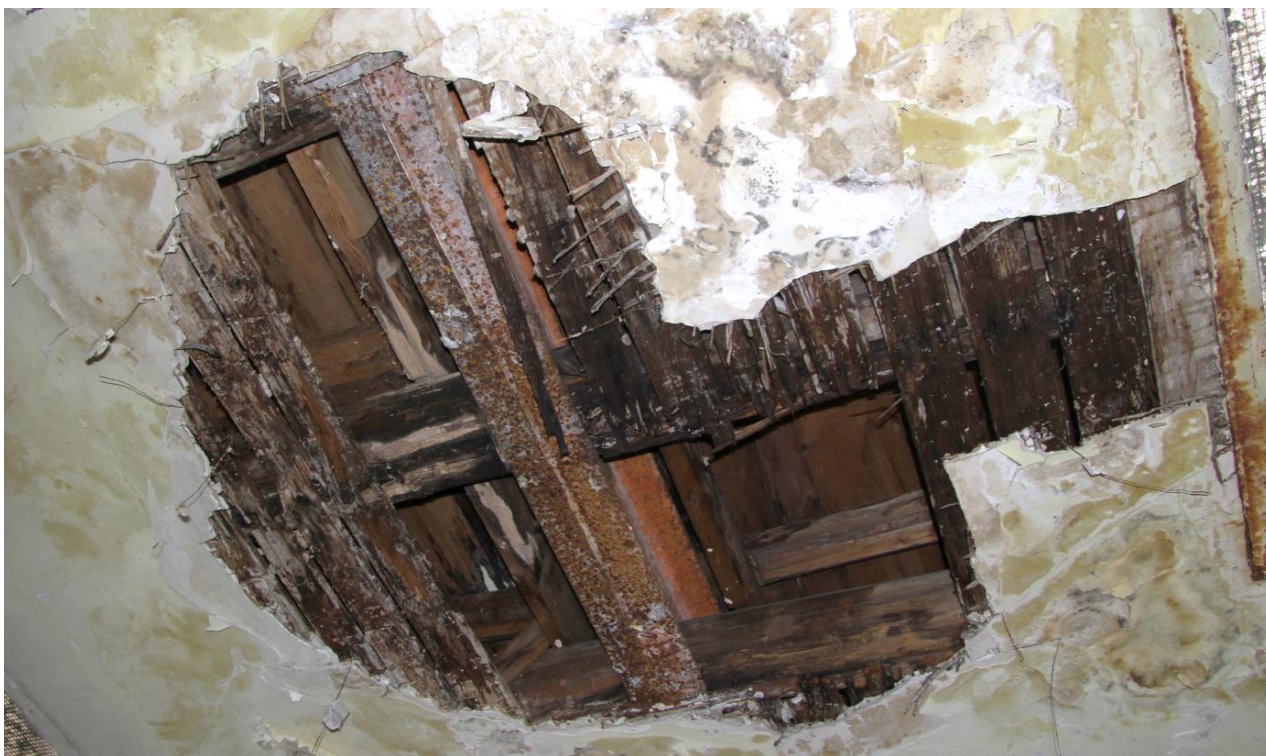
Obr.: 14 Poškodená strecha
