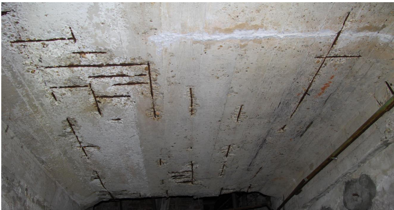
Obr.: 11 Poškodená krycia vrstva – je možné reprofilovať
