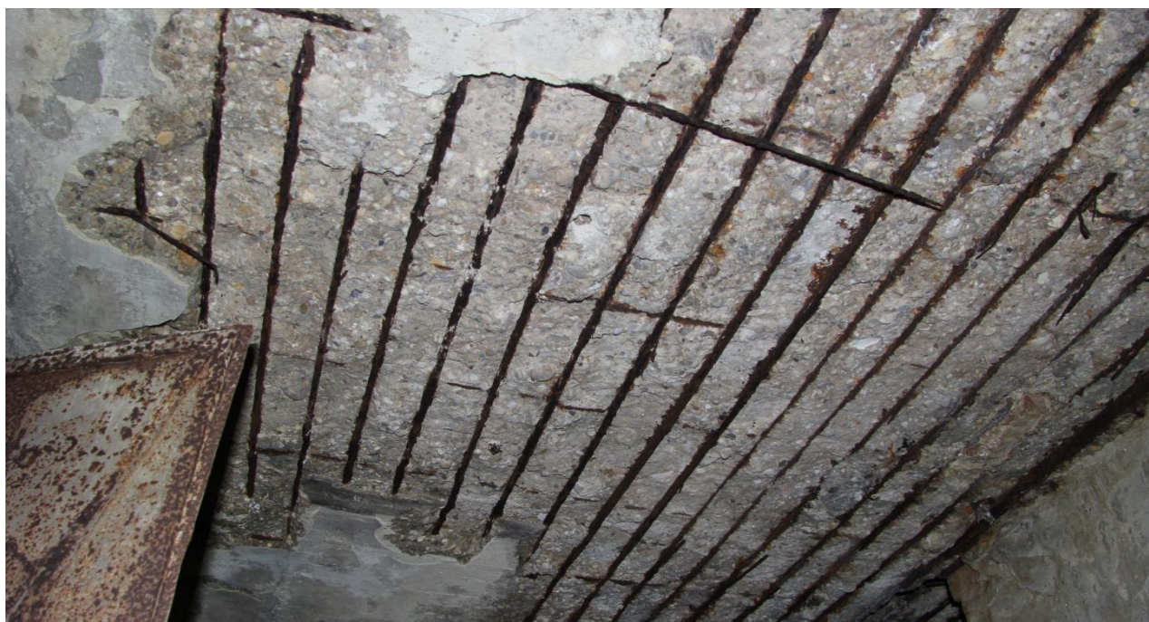
Obr.: 8 Poškodená krycia vrstva
