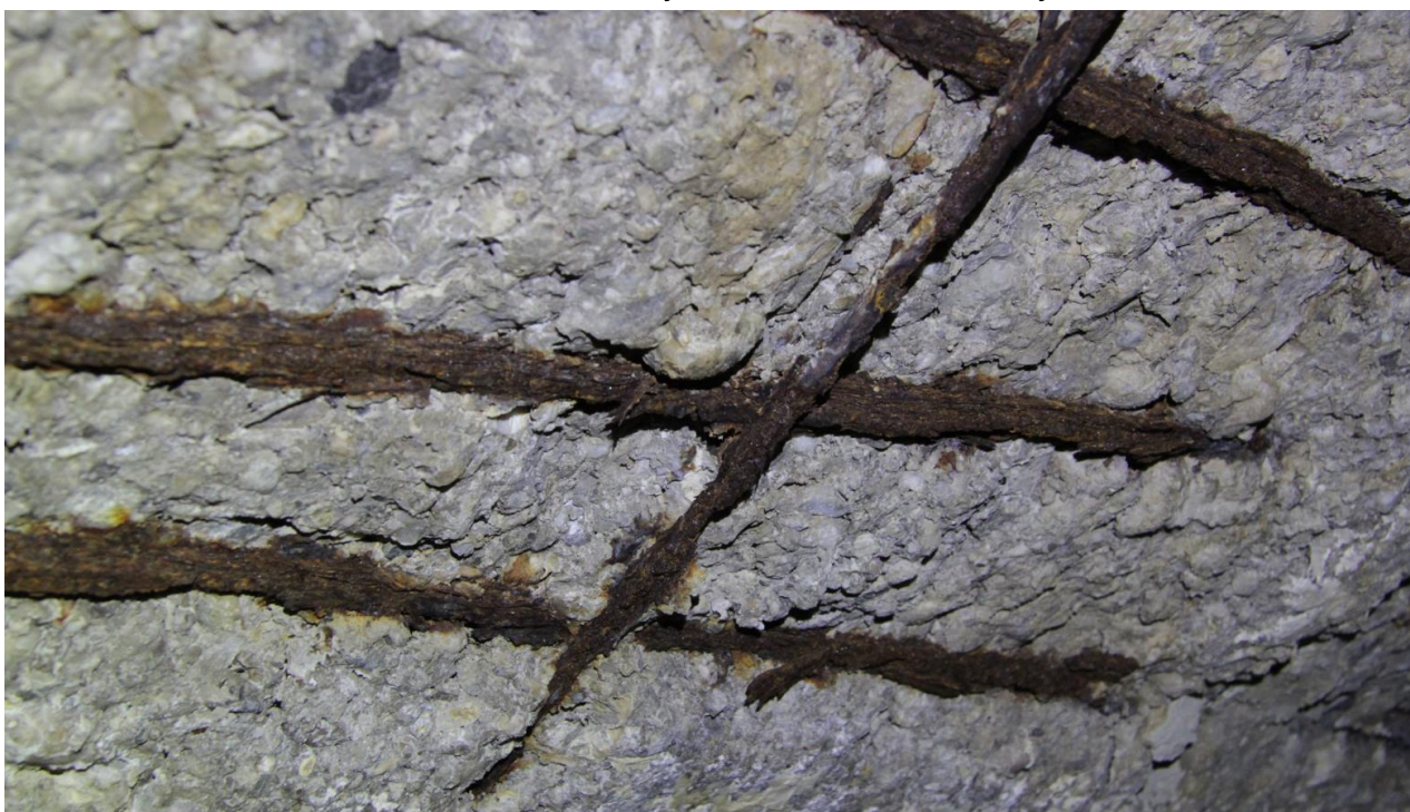
Obr.: 4 Poškodená krycia vrstva a detail skorodovanej výstuže
