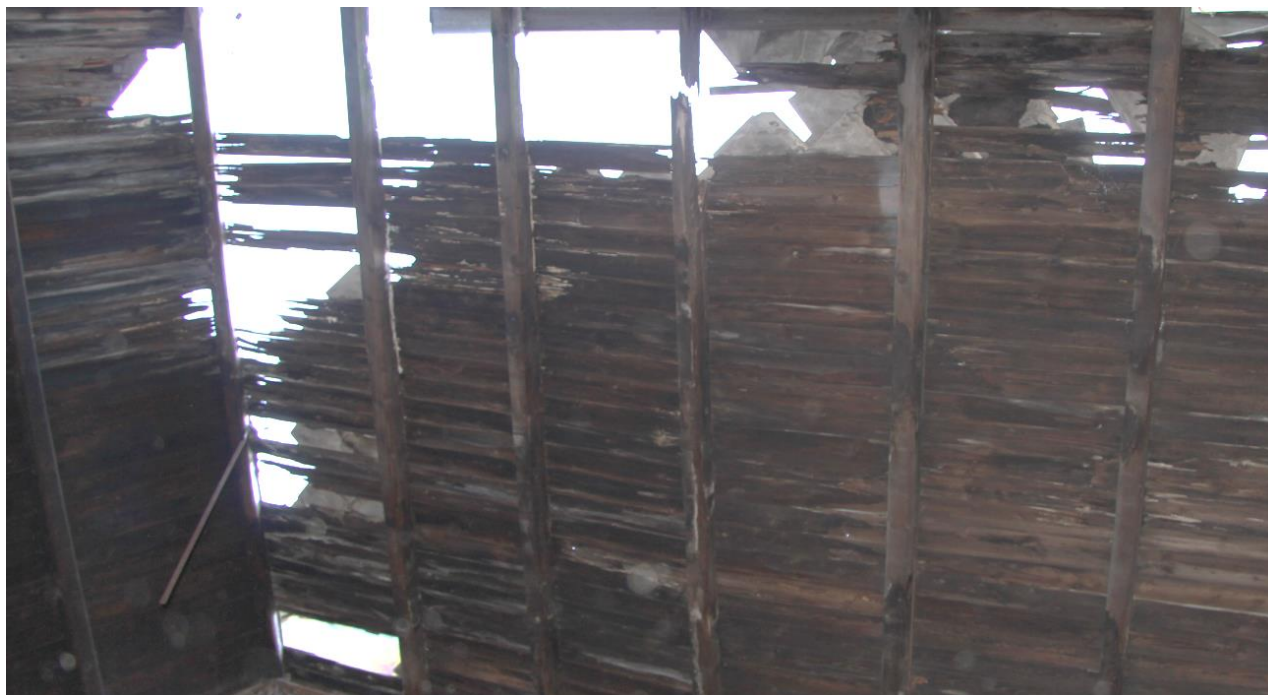
Obr.: 12 Poškodená strecha
