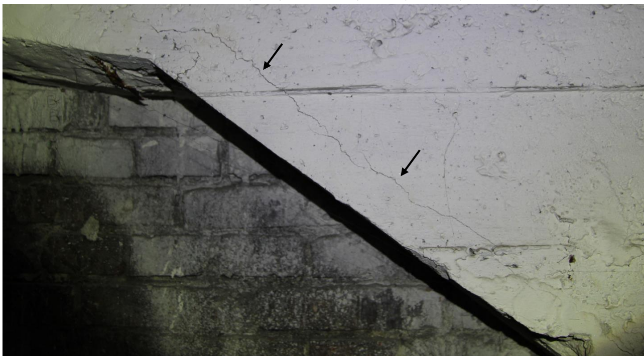
Obr.: 6 Pohľad na rebro stropu – poškodená spodná výstuž, odprasknutá krycia vrstva
