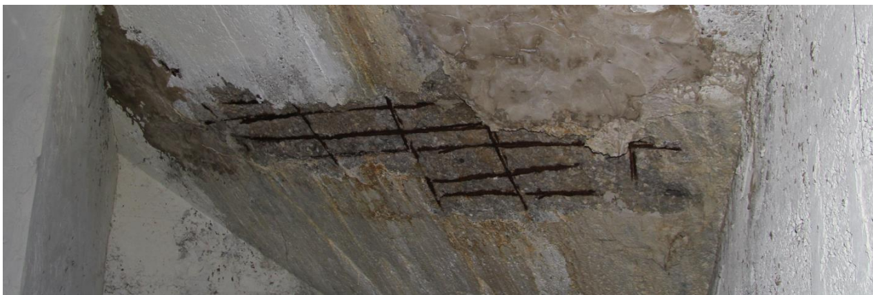
Obr.: 3 Poškodená krycia vrstva a skorodovaná výstuž
