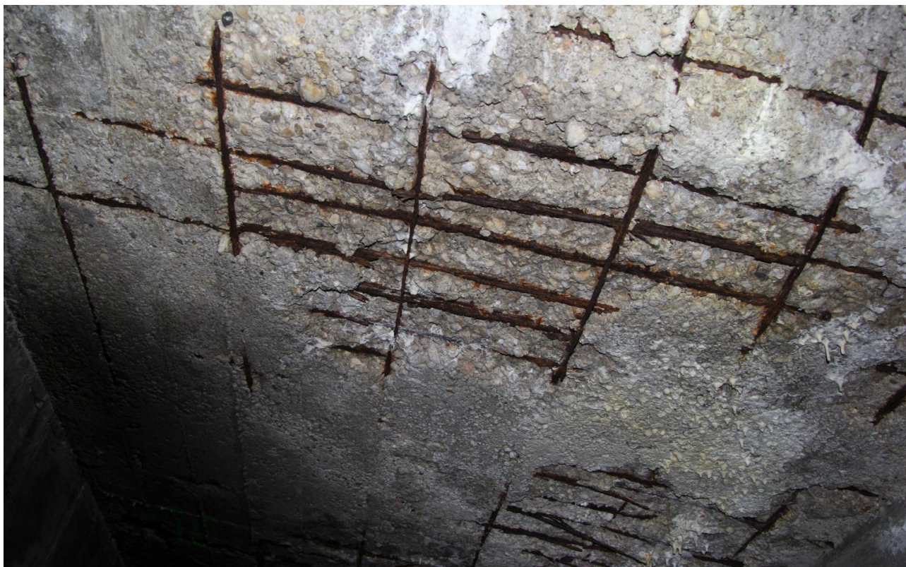
Obr.: 7 Poškodená krycia vrstva a detail skorodovanej výstuže
